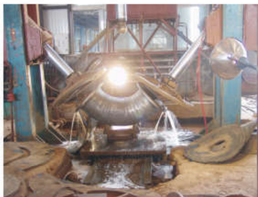
8. 水压试验 Hydraulic press test
